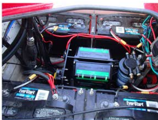
配線系・電気系の改造
